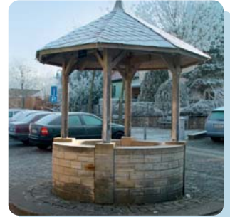
Abbildung D: gemauerter Schachtbrunnen
