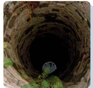
Blick in einen Schachtbrunnen
